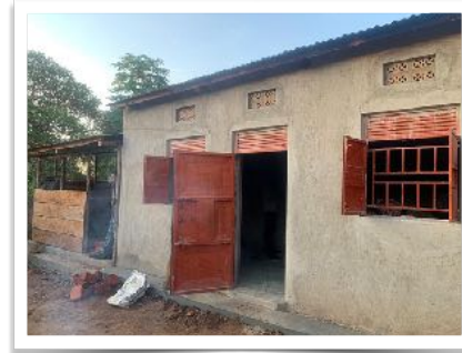
Küchengebäude für die Bakery Ausbildung
